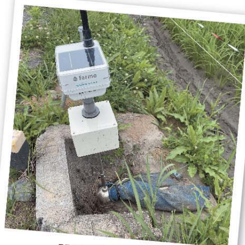
設置状況(新城市)
