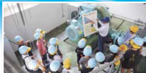
小水力発電設備の説明を受ける様子(大島ダム)
