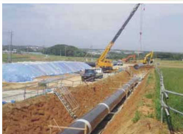
併設水路(鋼管布設)
